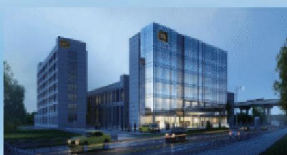
Νέα Βάση Wuhan (Βιομηχανικό Πάρκο 400.000m 2 )
